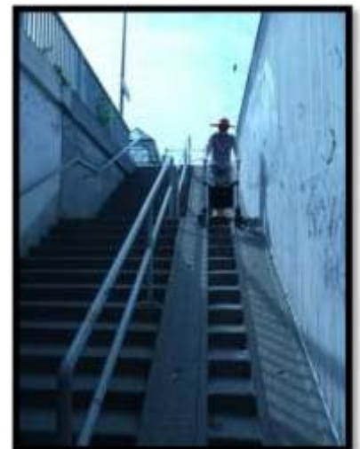
Abbildung 4: Ortsbegehung Berghausen- zu steile Bahnstufunterführung
